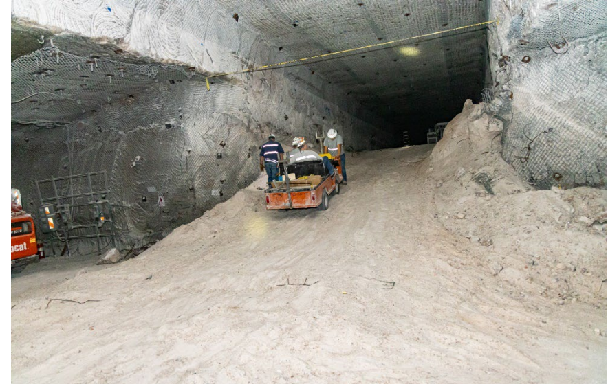
Se construye una rampa para permitir el acceso de la máquina minera a la parte trasera (techo) en E-140
